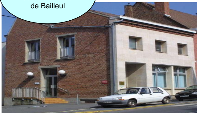
Façade CMP-CATTP "Camille Claudel" de Bailleul
